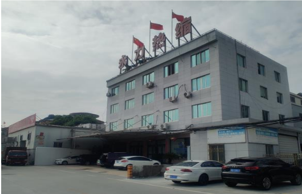
图 3.3-5 企业西侧现状（永力热缩材料有限公司）
