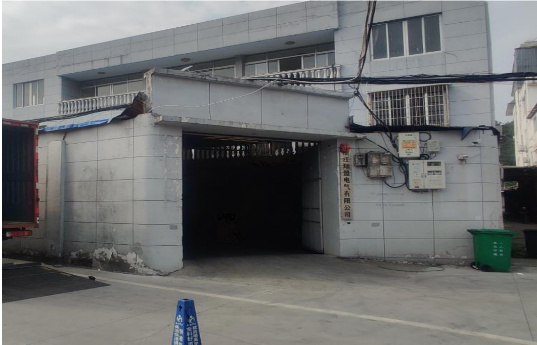
图 3.3-3 企业东侧现状（浙江翔盟电气有限公司）
